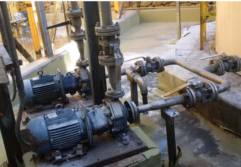
Opciones de bombas centrífugas de proceso con acople magnético para movimiento de fluidos corrosivos.
