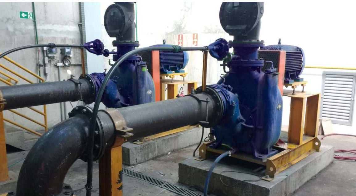
Opciones de bombas autocebantes para fluidos abrasivos, cristalizantes y con partículas en suspensión.
