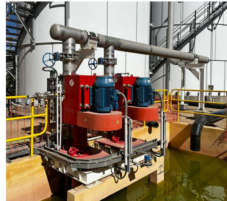
Opciones de bombas centrífugas horizontales y verticales para movimiento de lodos.
