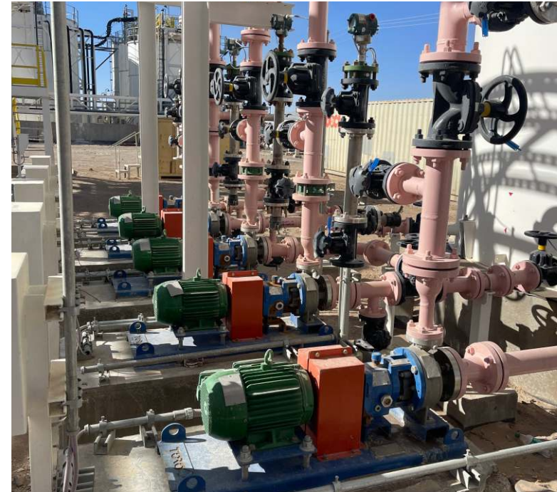
Opciones de bombas centrífugas de proceso para trasvase de fluidos corrosivos, abrasivos, y con sólidos en suspensión.
