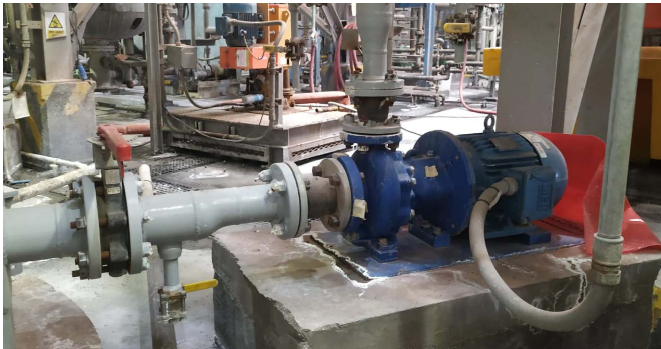
Opciones de bombas centrífugas de proceso con acople magnético para movimiento de fluidos corrosivos.
