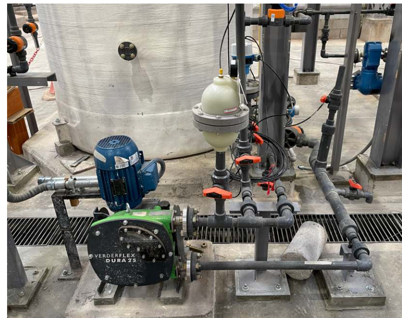
Opciones de bombas peristálticas para dosificación de fluidos corrosivos, abrasivos y tratamiento delicado de producto.
