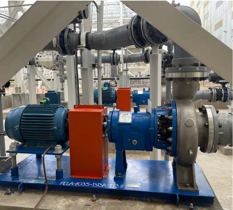
Opciones de bombas centrífugas de proceso para trasvase de fluidos corrosivos, abrasivos, y con sólidos en suspensión.
