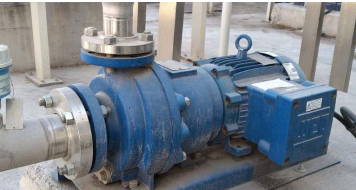
Opciones de bombas centrífugas, con sello mecánico o acople magnético, para movimiento de fluidos corrosivos.
