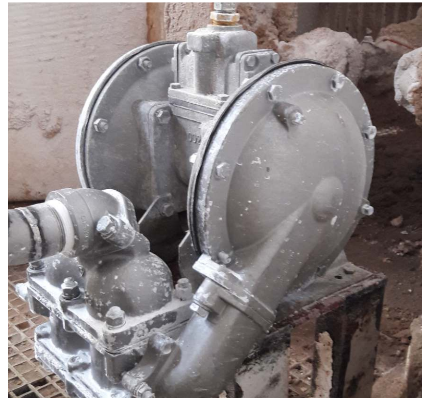
Opciones de bombas neumáticas de doble diafragma para el movimiento de fluidos corrosivos, abrasivos, y/o inflamables.
