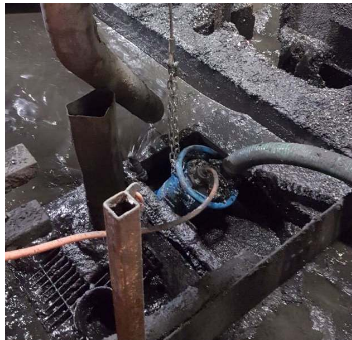
Opciones de bombas sumergibles para desagüe y drenaje de fluidos abrasivos y con sólidos en suspensión.
