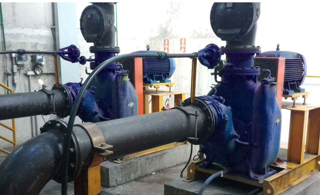
Opciones de bombas centrífugas de proceso para trasvase de fluidos corrosivos, abrasivos y con sólidos en suspensión.
