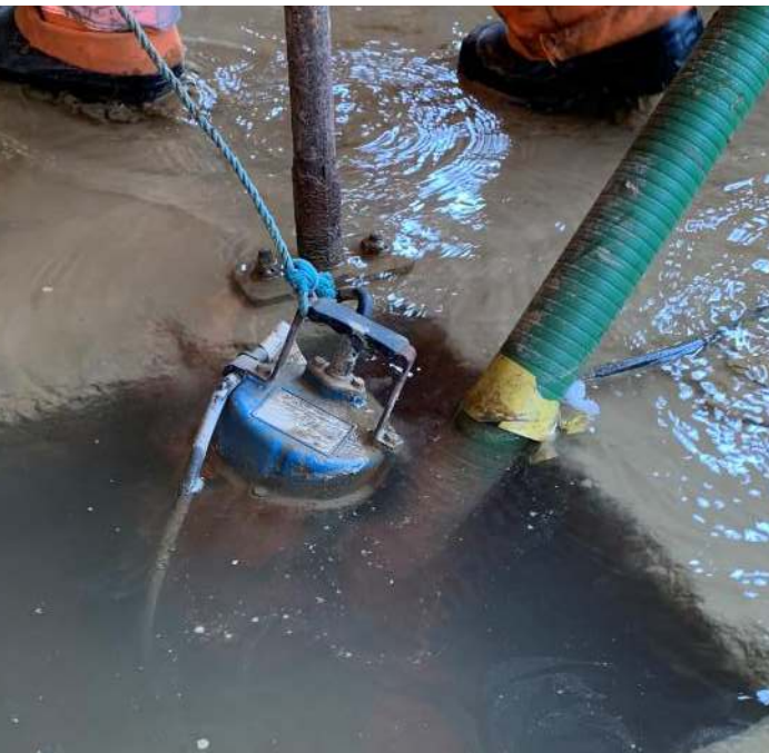
Opciones de bombas sumergibles para desagüe y drenaje de fluidos abrasivos y con sólidos en suspensión.
