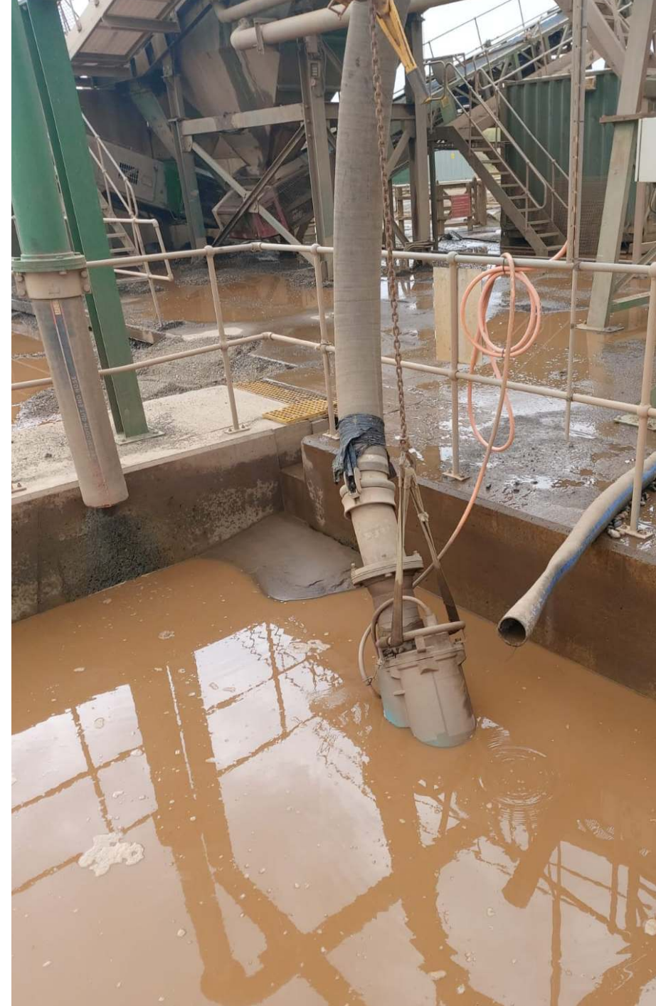
Opciones de bombas sumergibles para desagüe y drenaje de fluidos abrasivos y con sólidos en suspensión.
