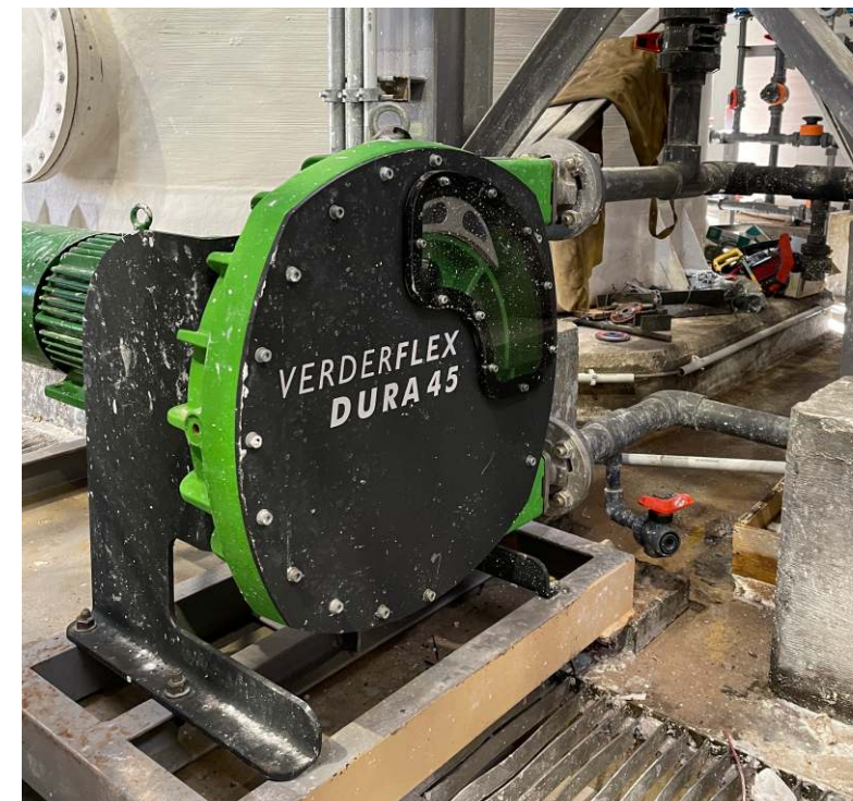
Opciones de bombas peristálticas para dosificación de fluidos corrosivos, abrasivos y tratamiento delicado de producto.
