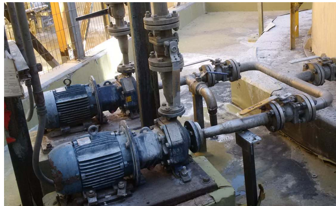
Opciones de bombas centrífugas, con sello mecánico o acople magnético, para movimiento de fluidos corrosivos.
